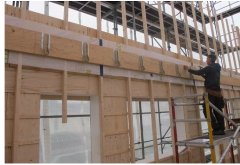
Figur 6: Yttervägg, montage av balkskor
