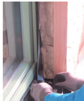
Figur 13: Överisolerad karm
