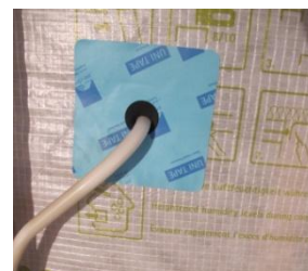
Figur 10: Lufttät genomföring
